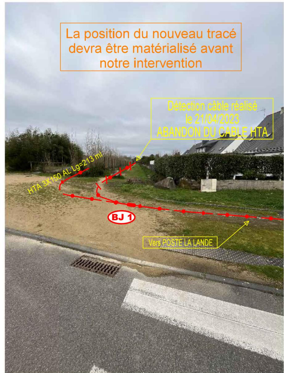
Détection câble réalisée
